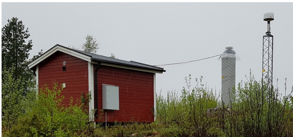
Figur 28. De 21 fundamentalstationerna har två antenninstallationer – på isolerad betongpelare samt på fackverksmast (vänster respektive höger i bild).
